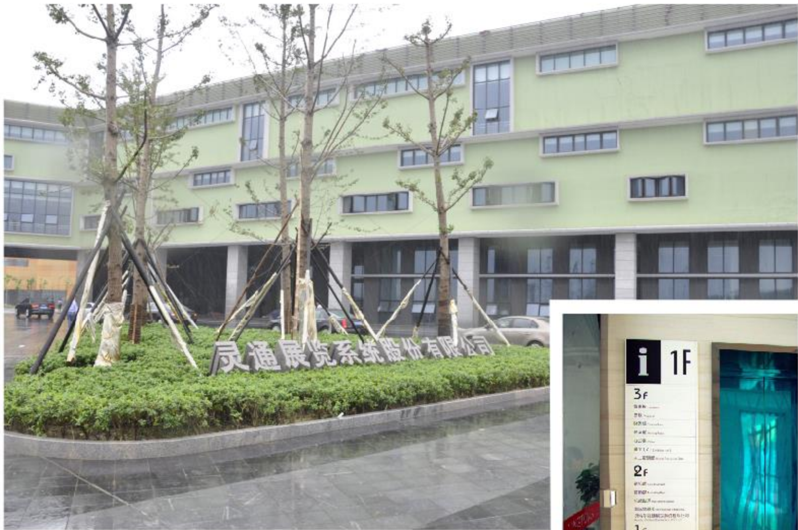
项目/IT:国家广告产业园灵通基地 地点/PLC:江苏·常州 项目概述/技术摘要:标识、标牌导视系统
